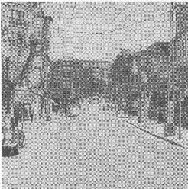
Lausanne, avenue d'Ouchy CARPAVE-Belag erstellt 1938
