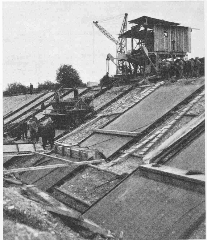
Bild 86. Betonieren einer Dammböschung im Staugebiet
