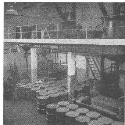
Teilansicht unserer Re-Raffinationsanlage
