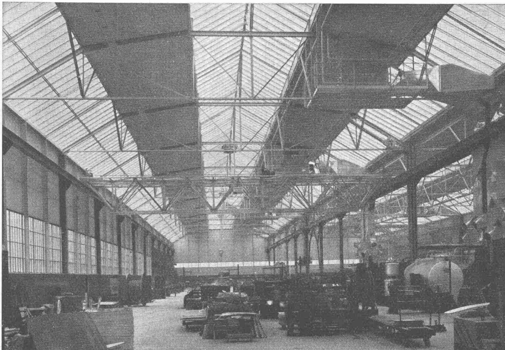
Produktionshalle, Krangerüst in Leichtmetall
