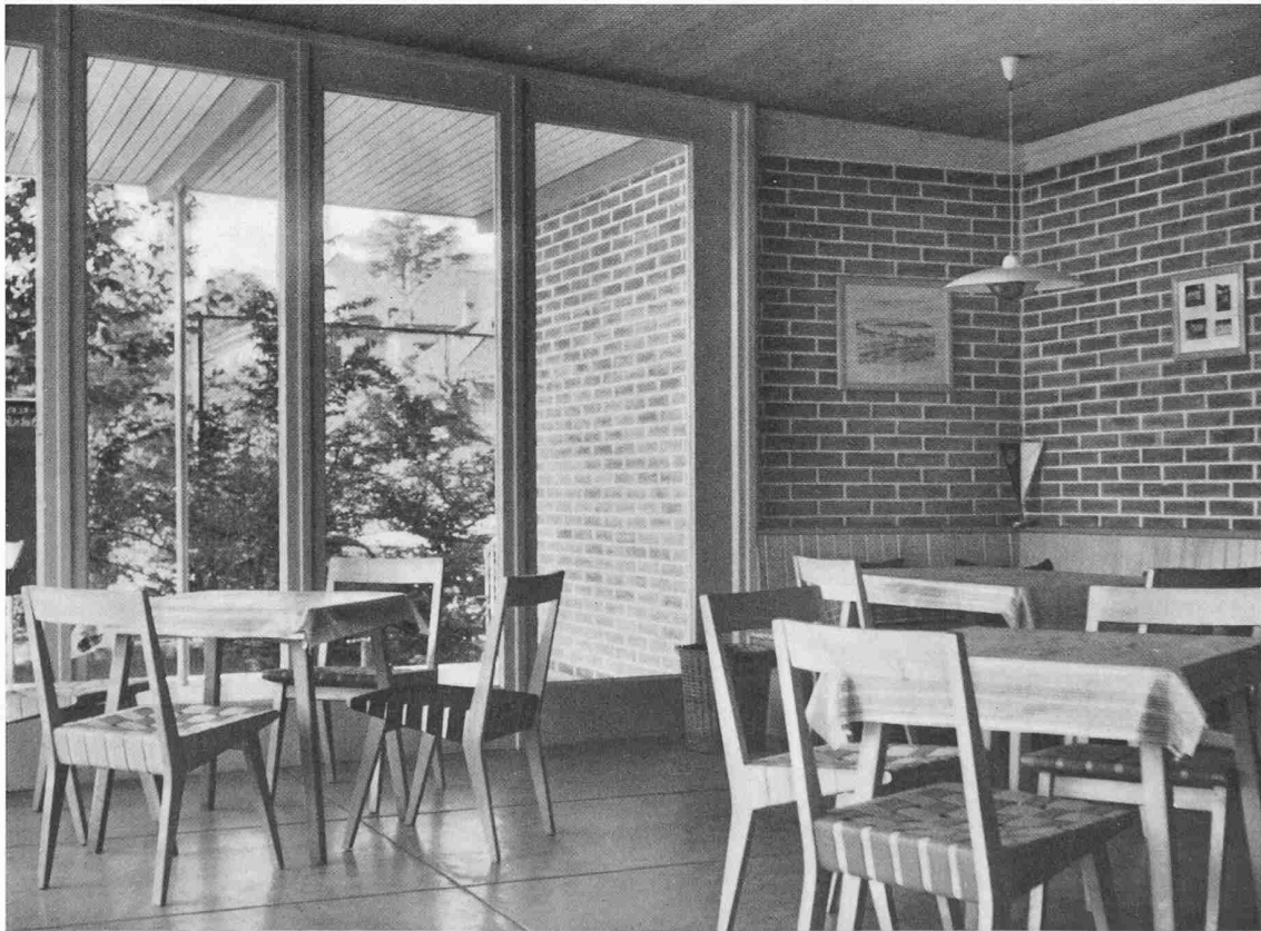
Innenansicht des Aufenthaltsraumes im Garderobengebäude
