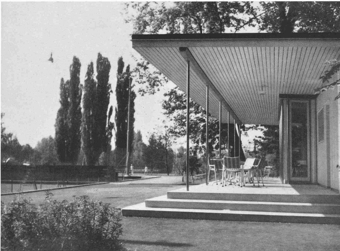
Ansicht der Terrasse aus Nordosten
