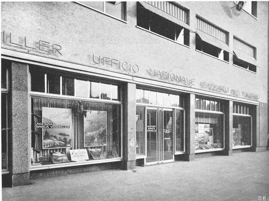
Bild 20. Einzelheiten der Fassade von Bild 19
