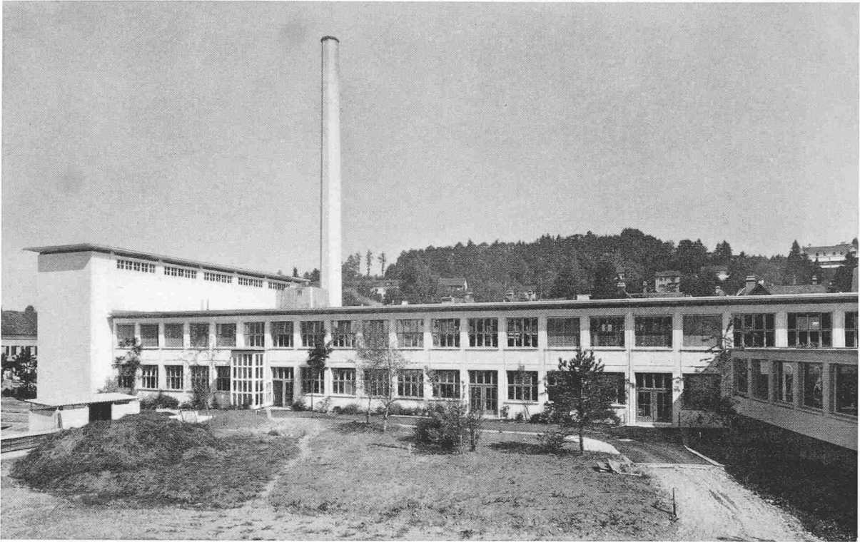
Kesselhaus und Betriebsgebäude von der Gartenseite
