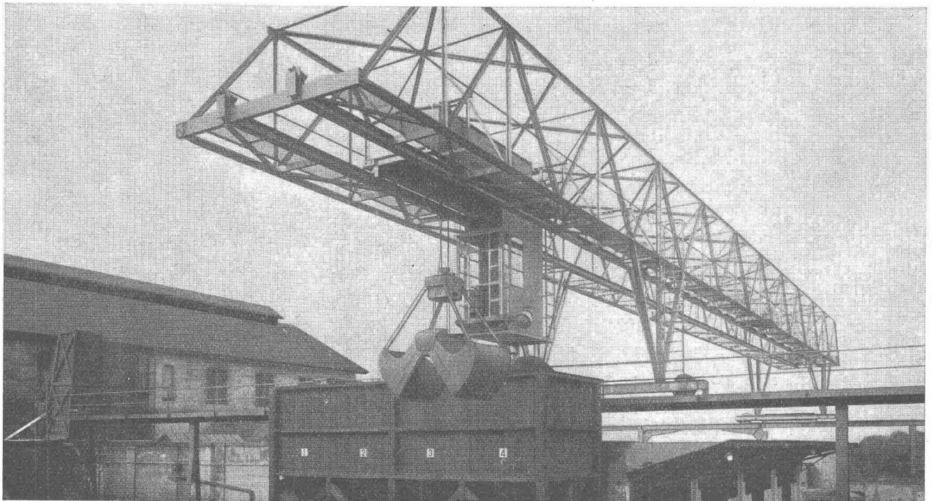
Verladebrücke in Schweisskonstruktion 2,5 t Tragkraft, 46 m Länge
