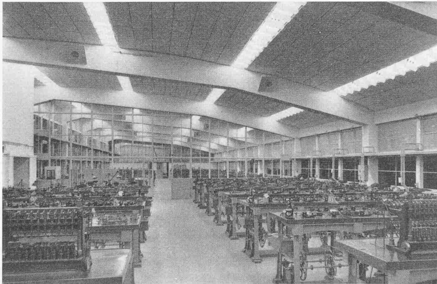
Bild 4. Versenkte Leuchtröhren-Reihe mit Blendschutz durch Metallraster in einem Fabrikraum (Ausführung Philips AG., Zürich)
