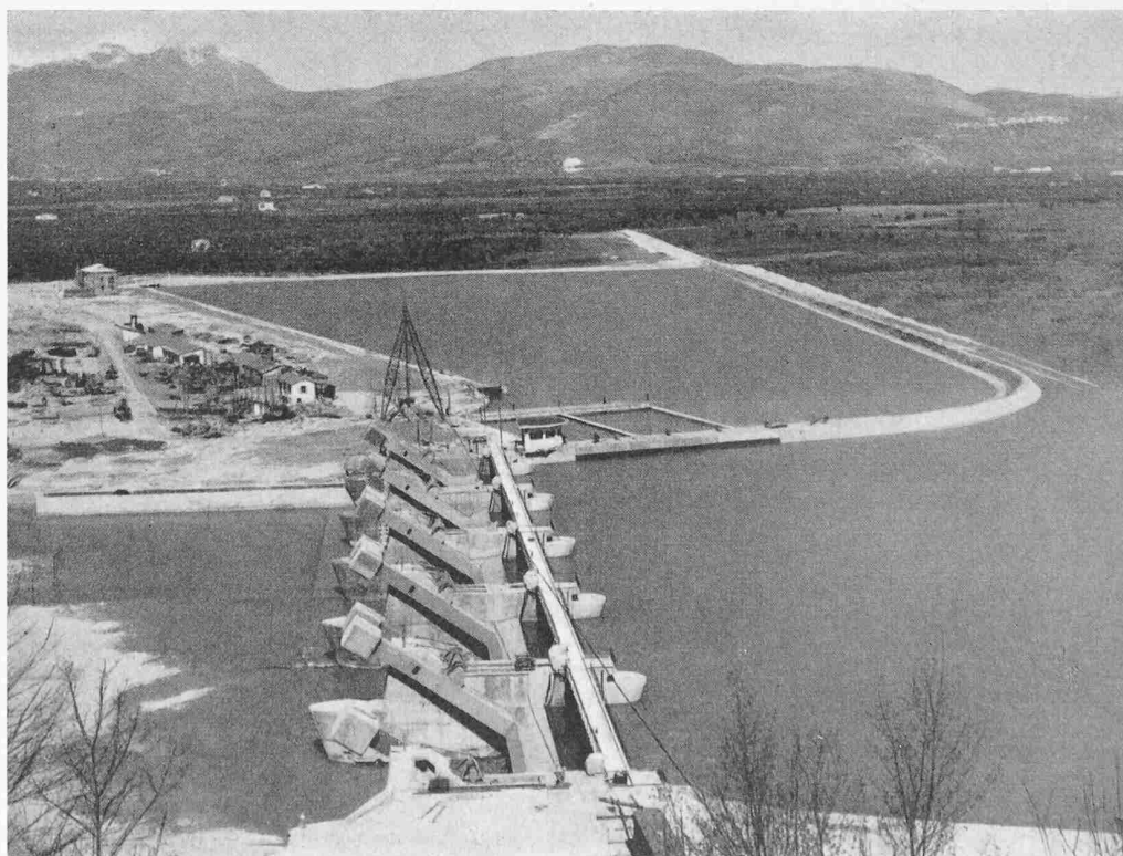
Bild 6. Die Wehranlage Volturno bei Neapel
