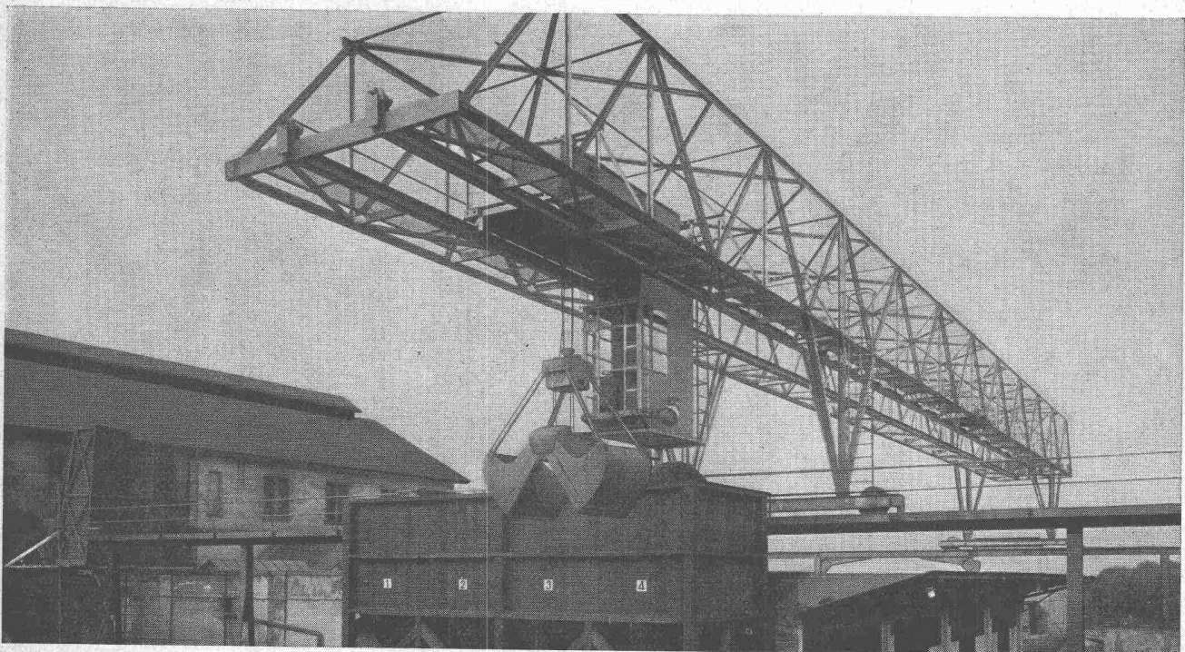
Verladebrücke in Schweisskonstruktion 2,5 t Tragkraft, 46 m Länge
