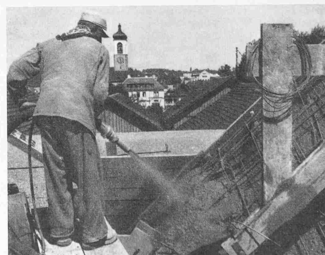
Bild 8. Betonieren nach dem Spritzverfahren der «Spribag», Zürich
