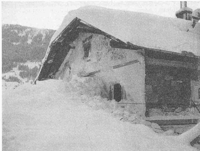
Bild 11. Auf etwa 7 m Höhe aufgestaute Schneemassen an der Frontseite des Bahnhofs Dalaas
