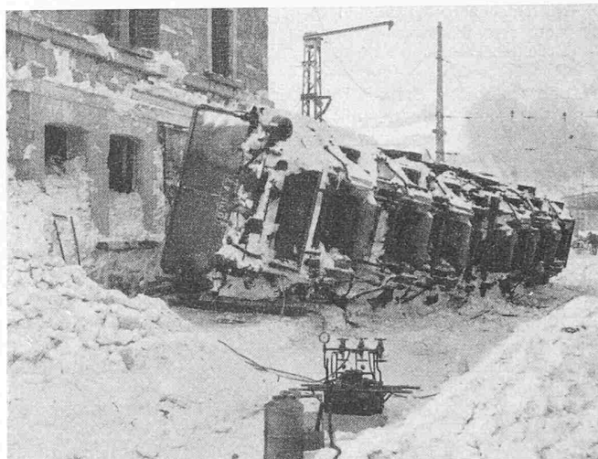
Bild 13. Westlicher, stehen gebliebener Gebäudeteil (wie Bild 11) mit davor liegender Lokomotive, nach Entfernen des Schnees
