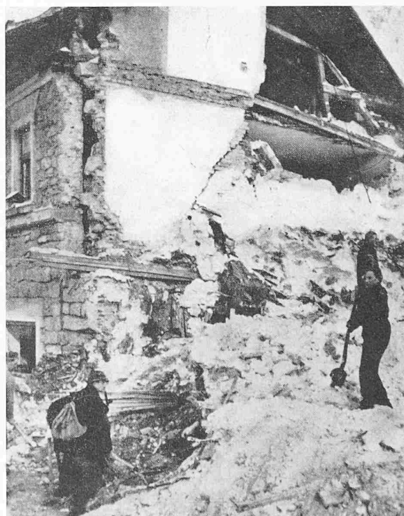
Bild 14. Zustand der Querwand des ersten Stockwerkes, Lawinenrichtung von rechts nach links
