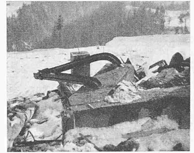
Bild 8a. Durch Lawine abgeogener Eisenständer
