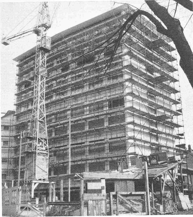
Bild 2. H-Rahmen-Fassadengerüst in Zürich
