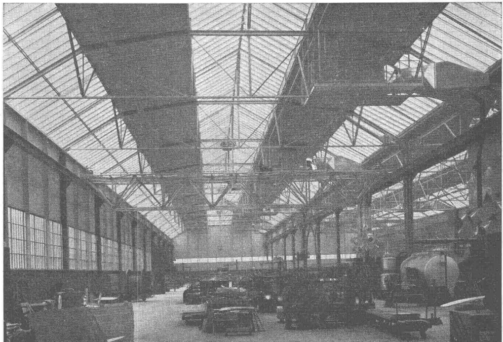
Produktionshalle, Krangerüst in Leichtmetall
