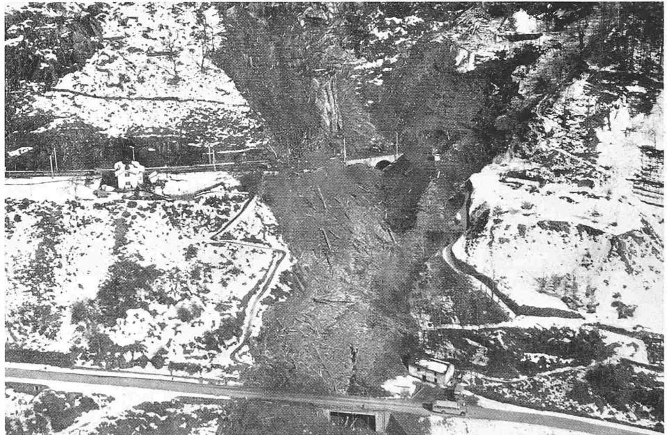
Bild 17. Grundlawinenverschüttung bei Lavorgo, 1951. Höhe der Auf- stauung 25 m über den Gleisen
