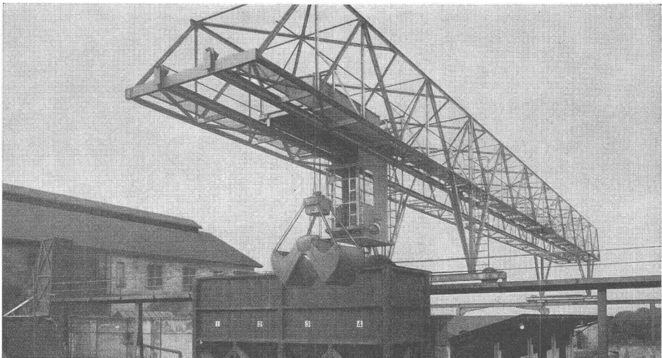
Verladebrücke in Schweisskonstruktion 2,5 t Tragkraft, 46 m Länge
