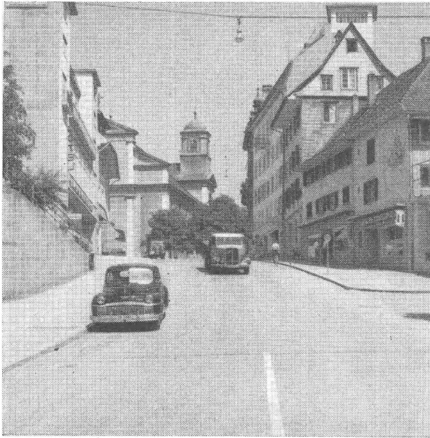
Mühlegasse Olten • Steilrampe mit Bitumen-Rauhbelag
