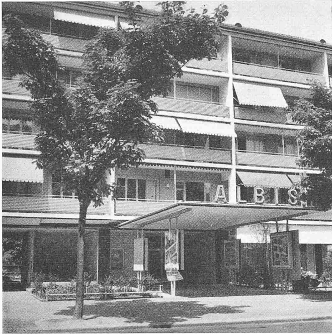
Hauptfassade an der Albisriederstrasse
