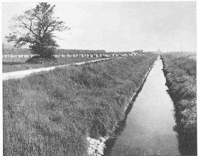
Canal oriental. L'arbre en surélévation permet de juger du tassement des tourbes
