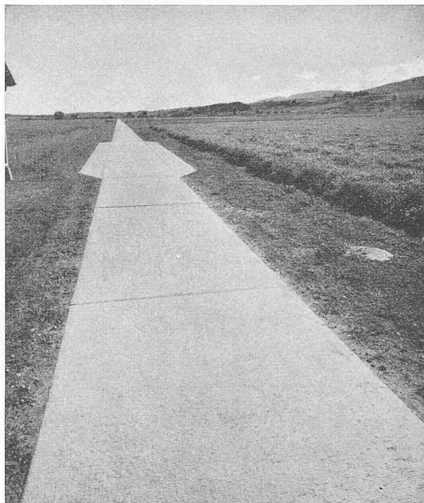
A droite: Plaine de l'Orbe. Chemin de 4 m. de largeur avec dalle de béton de 2,80 m.; place d'évitement. (Cliché Routes en béton S. A. Wildegg)
