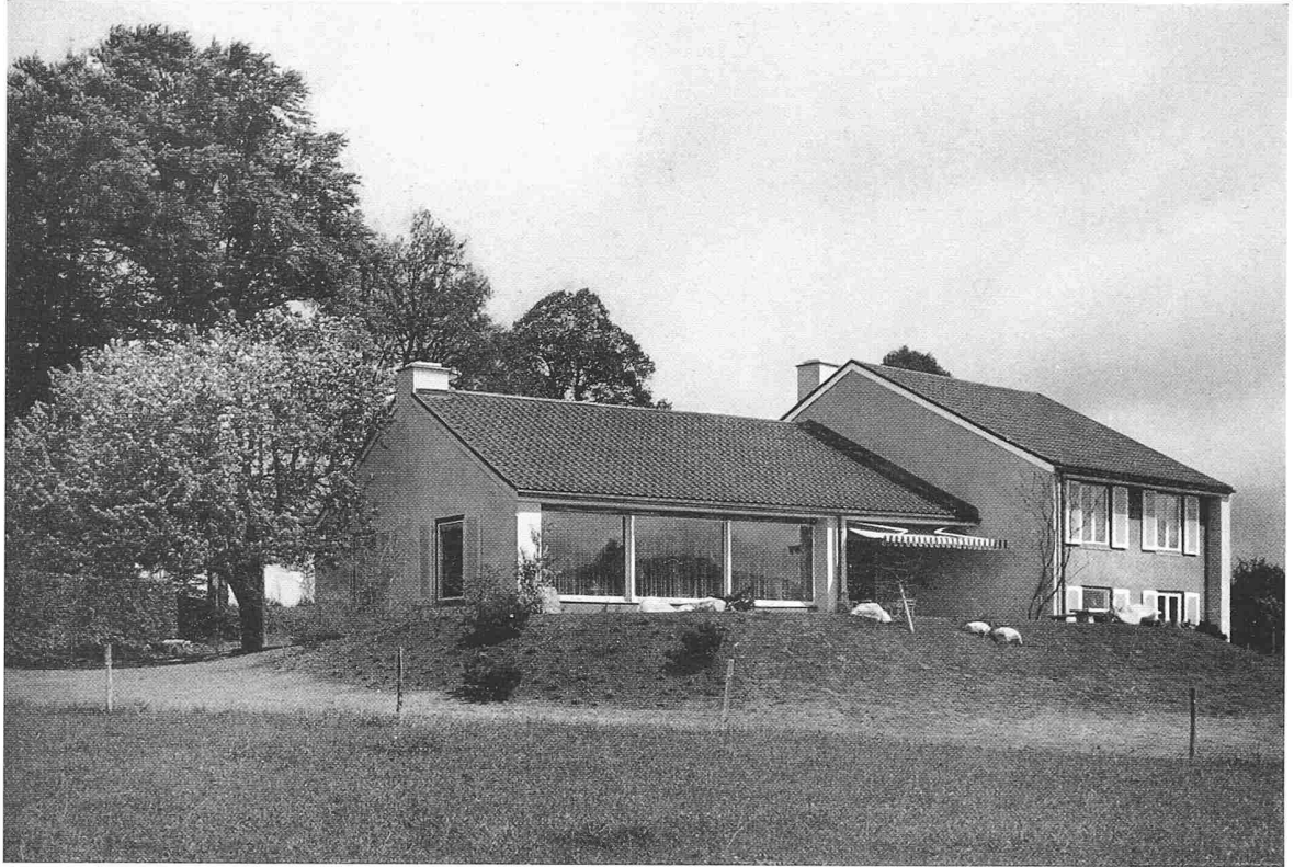
Ansicht aus Südwesten
