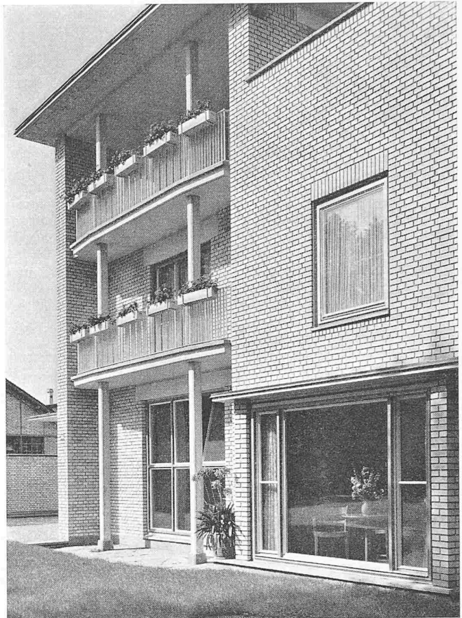
Bild 10. Südostecke des Wohlfahrtshauses
