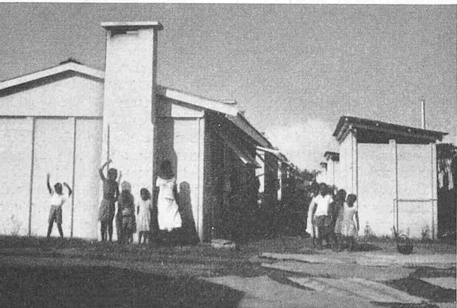
Bild 4. Stirnseite mit Nebenbau
