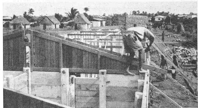
Bild 10. Befestigen der Holzbinde
