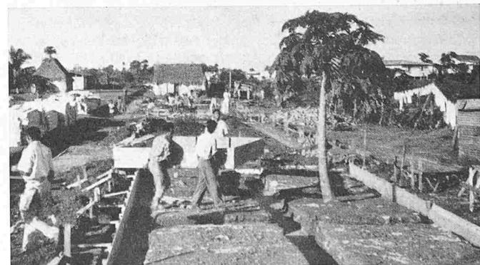
Bild 11. Vorbereitungen zum Aufstampfen der Beton-Grundplatte
