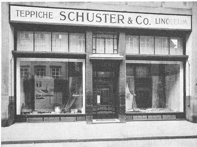
Bild 1. Fassade Multergasse vor dem Umbau
