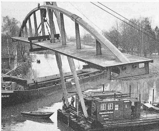
Bilder 1 und 2. Einschwimmen der Mittelträgerbrücke in Meppen am 5. April 1955
