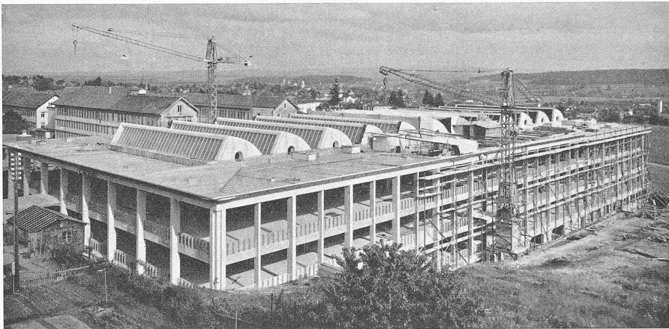
Bild 13. Bauzustand im Mai 1955. Architektur: K. Hirschbühl. Bauausführung: Arbeitsgemeinschaft R. Bannwart & Cie., Solothurn/ Uhrenfabrik Lanco in Solothurn C. von Arx AG., Olten
