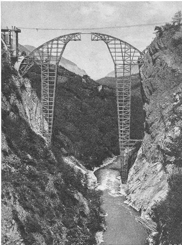
Bild 4. Lehrgerüst der Strassenbrücke über die Tara-Schlucht, Jugoslawien, 1938 - 1940, System Coray. Stützweite 110 m, Höhe 141 m. Projekt und Ausführung: Ingenieurbureau R. Coray, Chur. Ein orkanartiger Sturm versetzte das Gerüst in horizontale Schwingungen mit maximalen Ausschlägen am oberen Ende von \pm 1 m, ohne nachteilige Folgen
