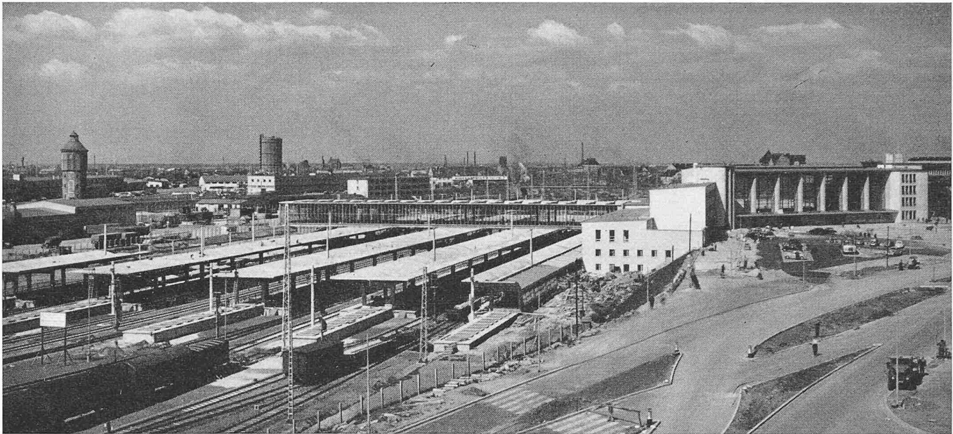
Bild 3. Gesamtansicht der Bahnsteige mit Empfangsgebäude
