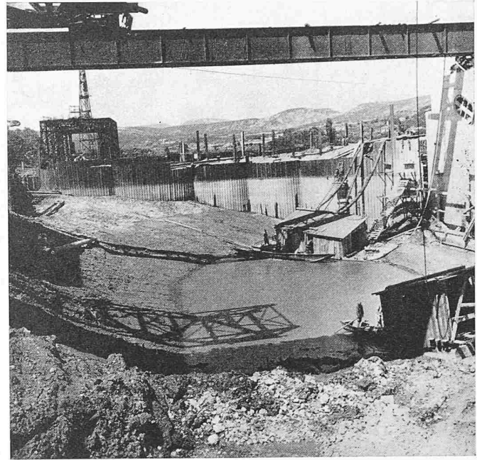
Bild 10. Abschluss der Schifffahrtsöffnung von 45 m durch Zellenfangdämme
