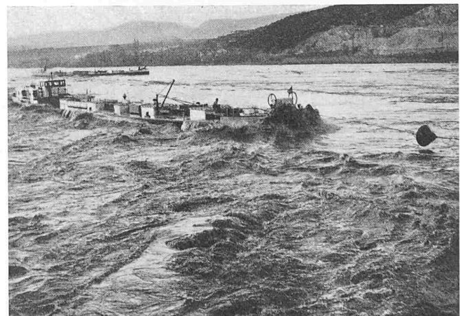
Bild 12. Stauwehr Donzère, Durchschleppen eines Tankers durch eine Oeffnung bei einem mittleren Hochwasser (5000 m 2 )
