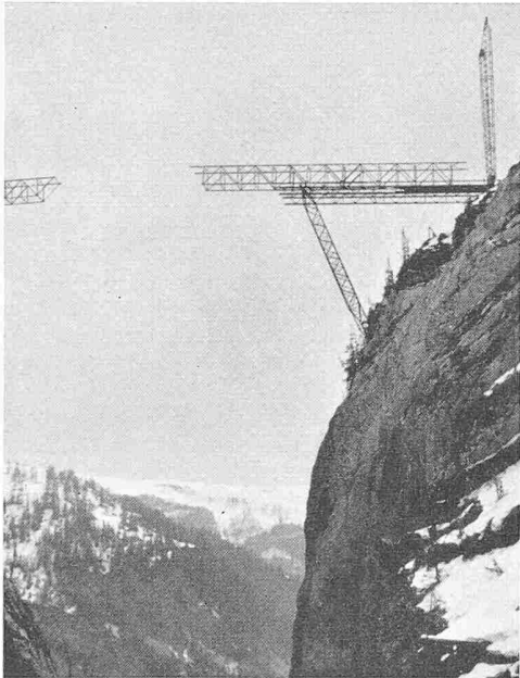
Bild 11. Montage der Brücke auf dem rechten Ufer, Ansicht von Norden
