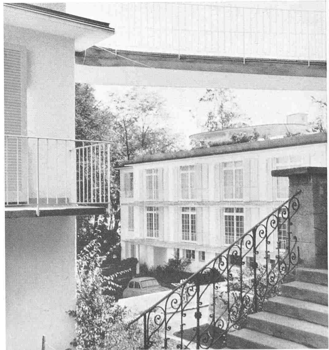
Blick in den Hof des Einganges Seestrasse; im Vordergrund der alte Treppenaufgang, oben die Verbindungsbrücke zum Dachgarten des Hauses 2
