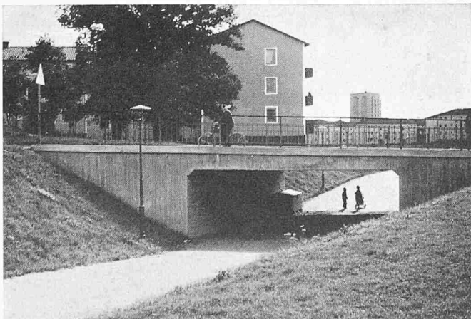
Bild 12. Fussgängerunterführung unter einer Fahrstrasse in Vällingby
