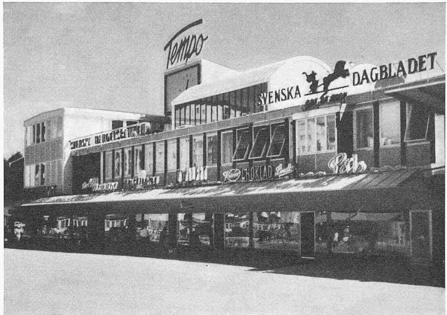
Bild 7. Ladenstrasse in Vällingby
