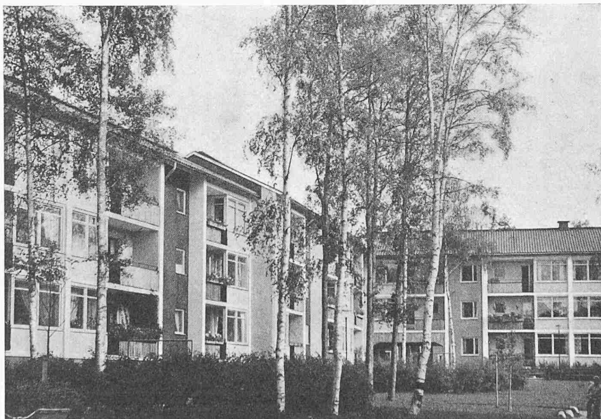
Bild 22. Miethäuser in Blackeberg
