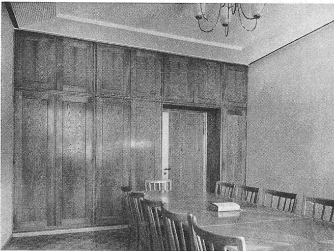
Bild 2. Sitzungszimmer, gegen die Kastenwand
