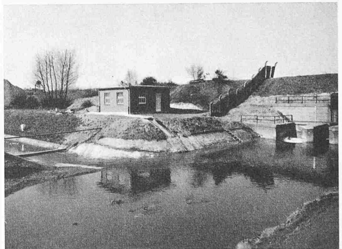
Bild 19. Kontrollstation zur Ueberprüfung der Wasserqualität
