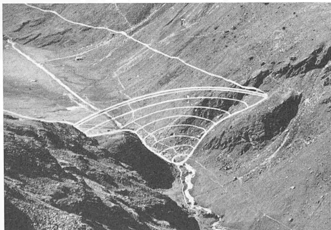
Bild 4. Moiry, Staumauerbaustelle vom Unterwasser gesehen (Photo Eidg. Vermessungsamt)
