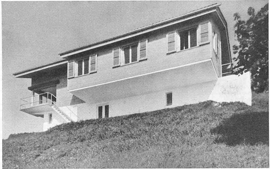
Ansicht aus Süden
