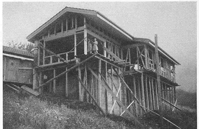
Rohbau aus Südwesten
