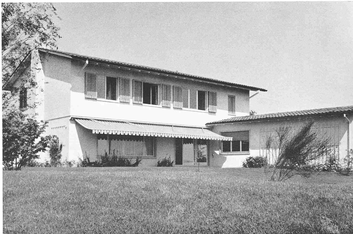
Einfamilienhaus E. H. in Ammannsegg (Solothurn) Architekt C. Steinmann, Zürich
