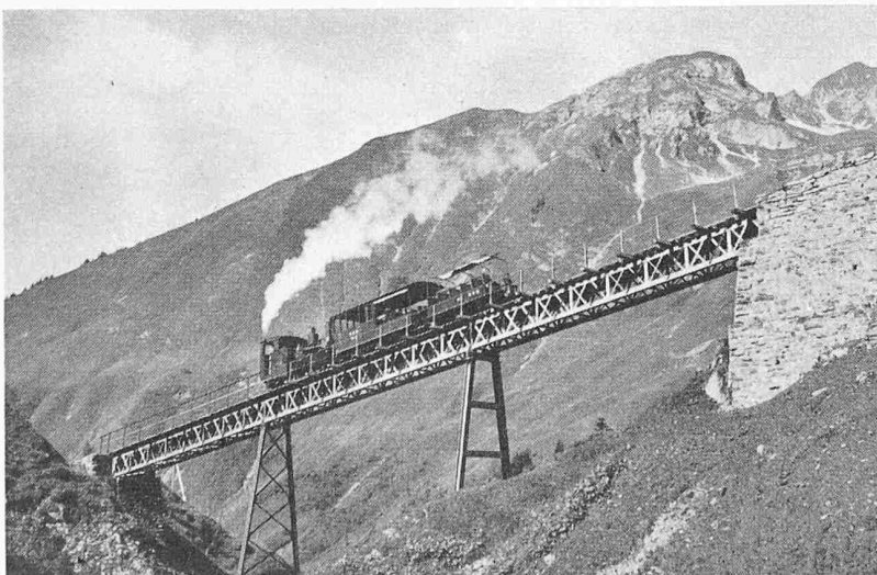
Bild 2. Die alte, eiserne Brücke mit dem 1931 ersetzten oberen Pfeiler
