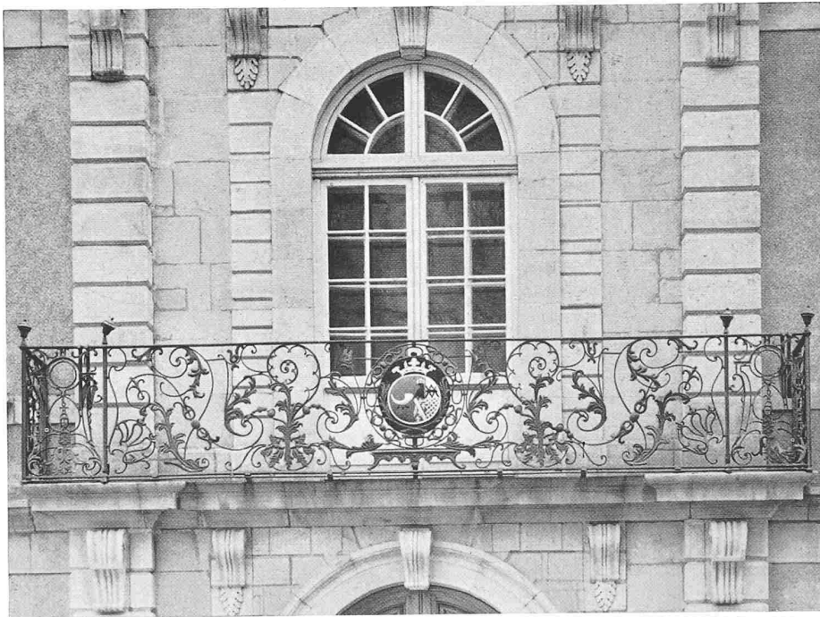
Rue du Pommier, No. 1. Détail
