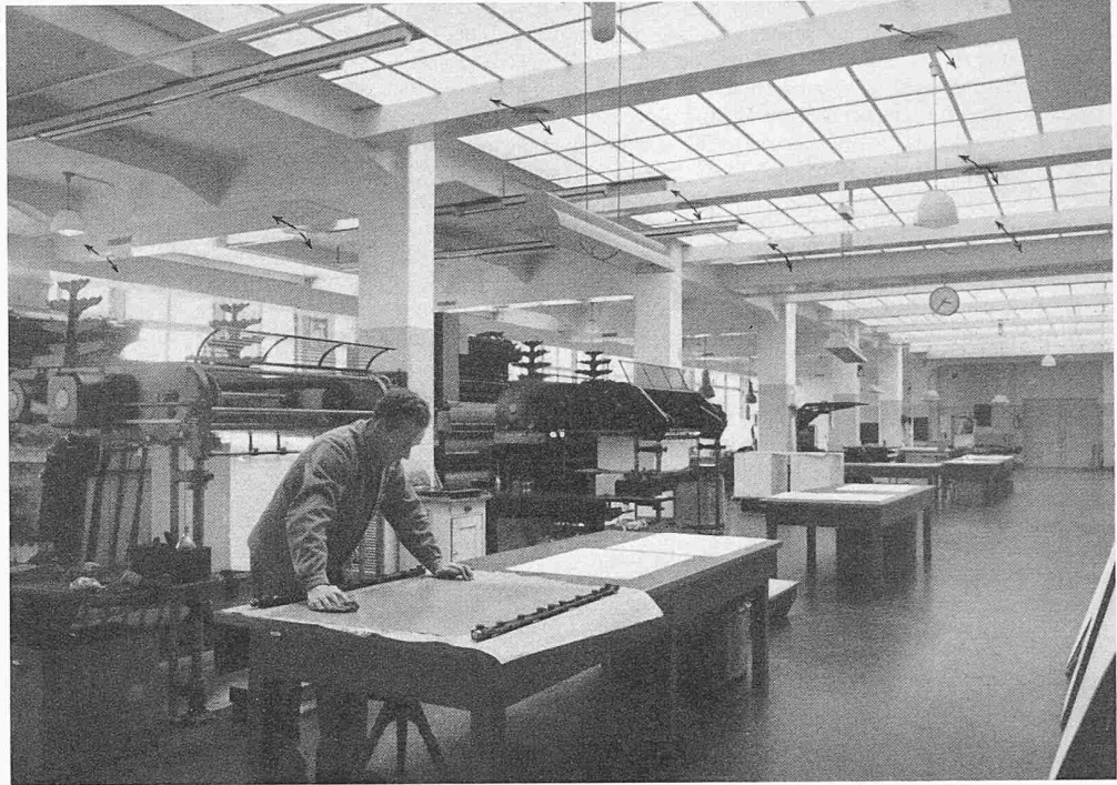
Bild 8. Teilansicht des Karten-druckraumes mit Zuluftkanälen an der Glasdecke und flachstreuenden Anemostaten zur Zuluftverteilung
