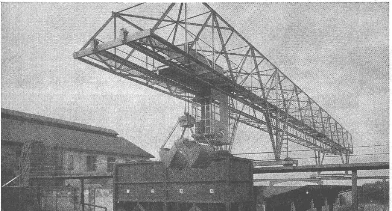
Verladebrücke in Schweisskonstruktion 2,5 t Tragkraft, 46 m Länge
