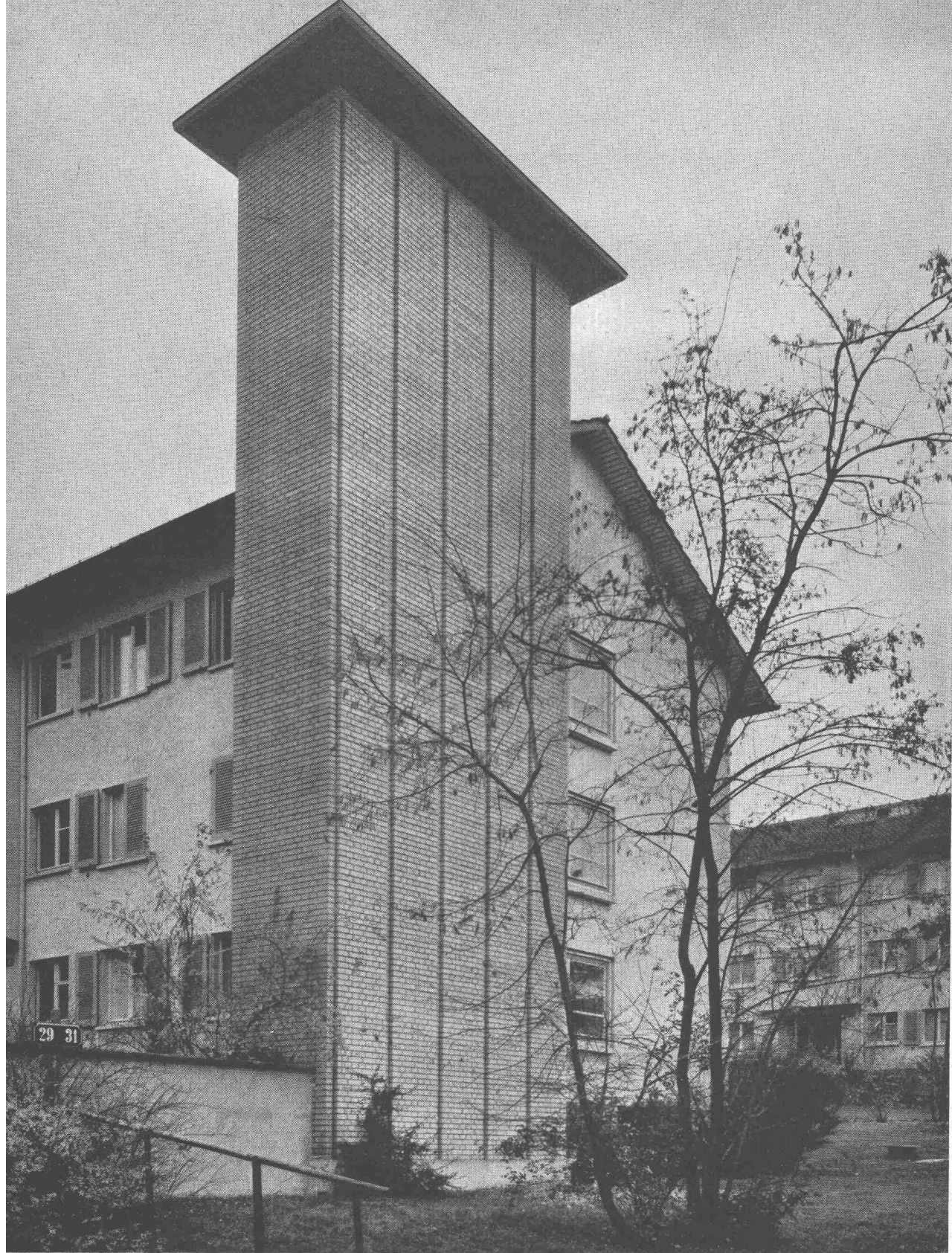
5-Züger Kamin einer Heiz- und Warmwasserzentrale
