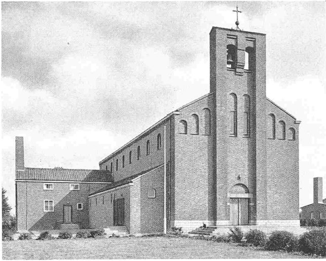
Römisch-katholische Kirche im neuen Land des Nordost-Polders. Reinkultur der traditionellen «Schule», eine Architekturrichtung, welche für die Zukunft wenig verspricht
