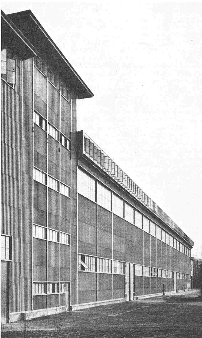
Bild 4. Ansicht der Nordfassade aus Osten
