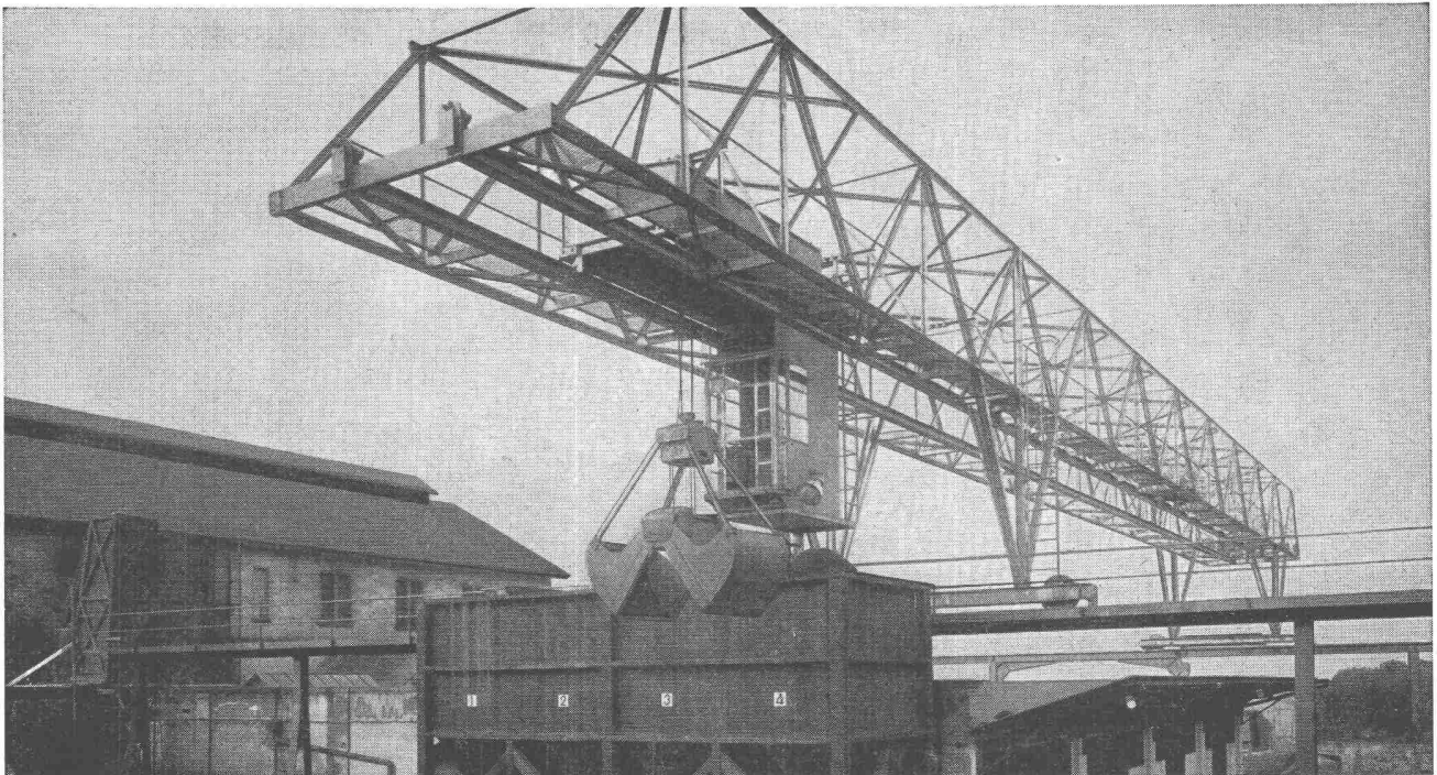
Verladebrücke in Schweisskonstruktion 2,5 t Tragkraft, 46 m Länge
