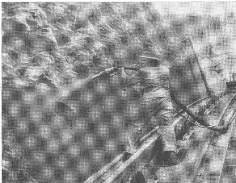
Felskonsolidierung bei der Druckleitung des Kraftwerkes Mauvoisin
