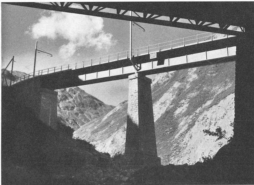
Bild 1. Fertige Brücke talwärts gesehen. Am oberen Bildrand ist noch ein Teil der Strassenbrücke sichtbar, über die der Umsteigeverkehr geleitet wurde.
